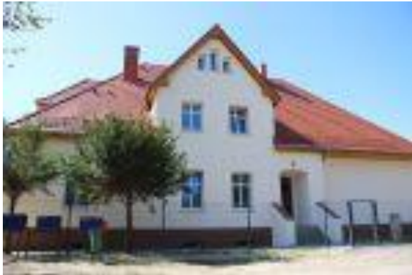
Świetlica po remoncie
