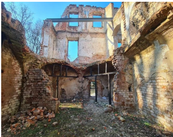
Stabilizacja i zabezpieczenie ścian z konstrukcji stalowych 2021r.
