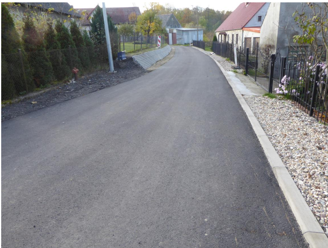
Droga po modernizacji w Grabiku
