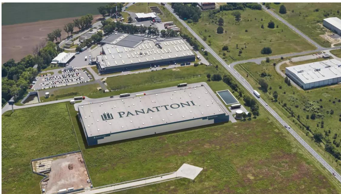
Hala produkcyjno – magazynowa Panattoni
