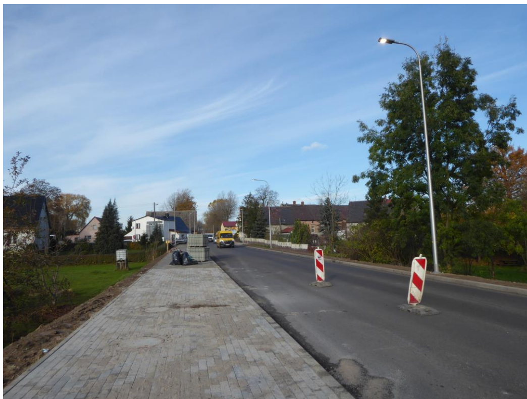
Oświetlenie i budowa drogi w m. Grabik
