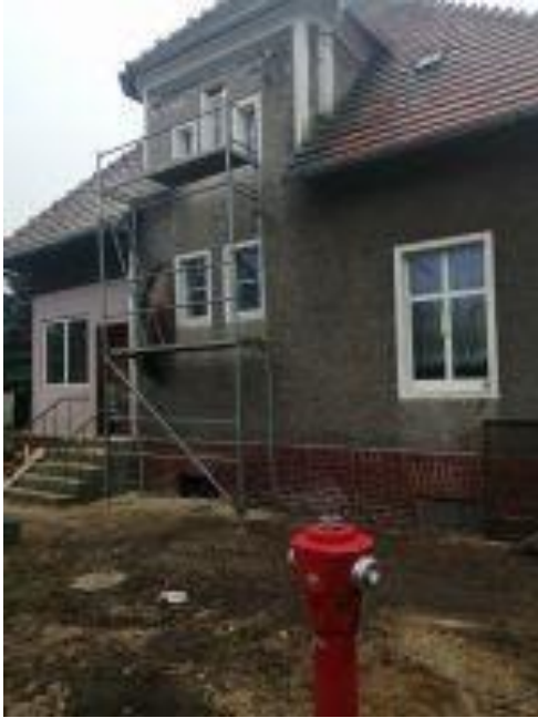
Świetlica przed remontem
