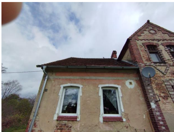
Bogumiłów- prace naprawcze
