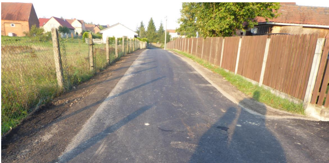
Droga w m. Łaz po modernizacji
