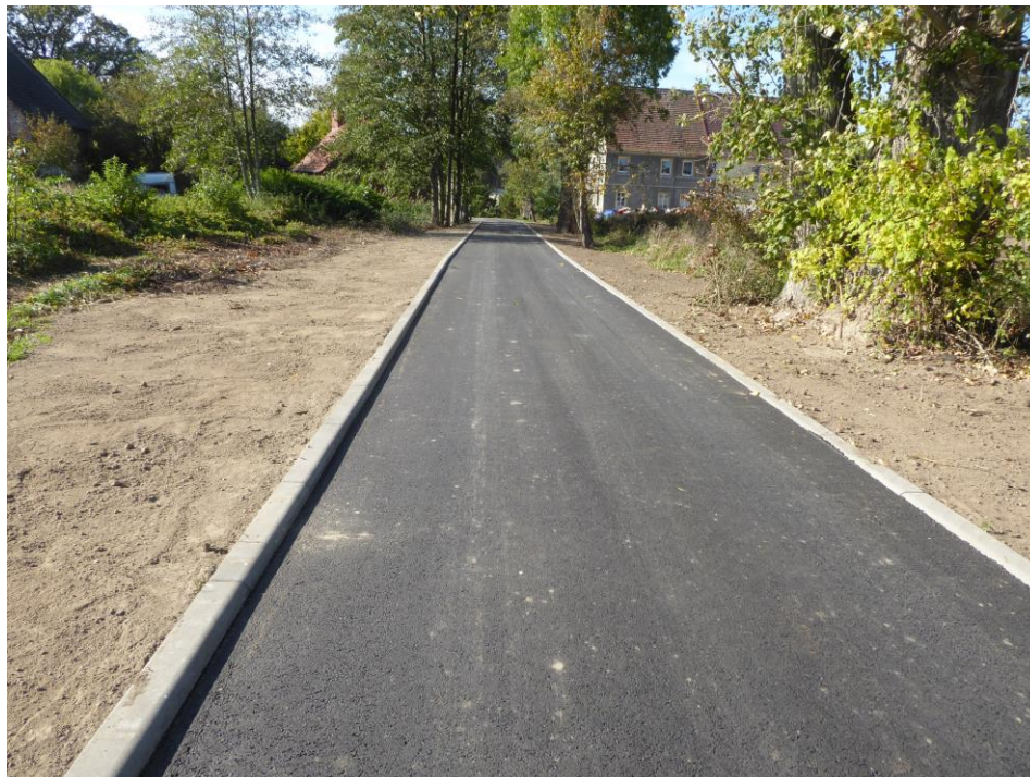
Droga po modernizacji w Drożkowie
