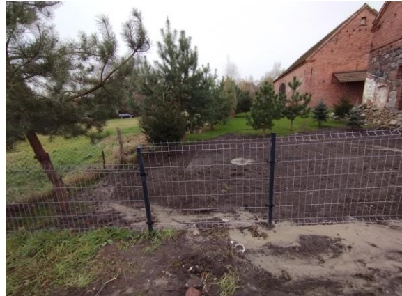
Nowe szambo do obsługi budynku nr 25, w którym jest świetlica gminna
