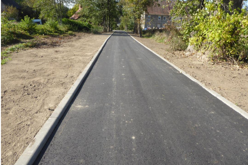
Odcinek drogi w m. Drożków po modernizacji
