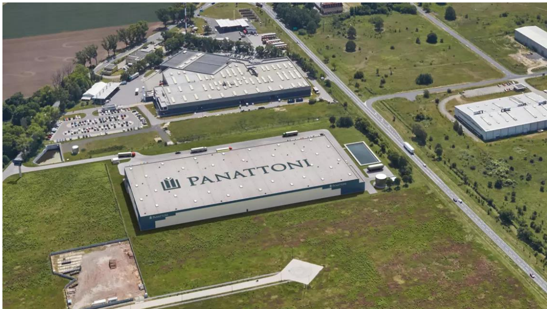
Hala produkcyjno – magazynowa Panattoni
