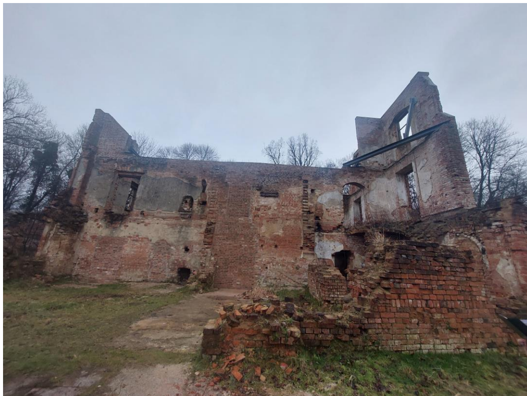
Widok na ścianę frontową.
