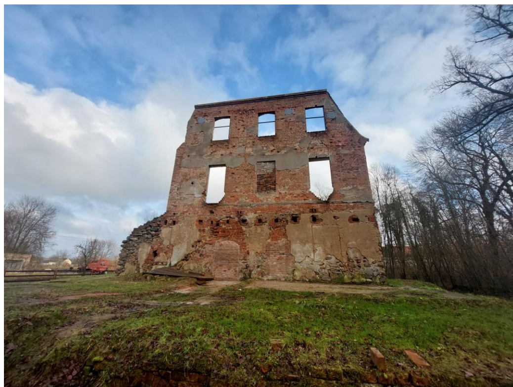
Widok na ścianę boczną.
