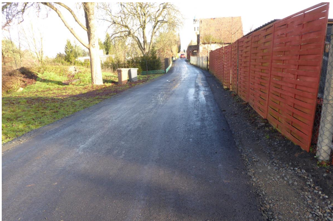
Nowy odcinek drogi – Mirostowice Dolne
