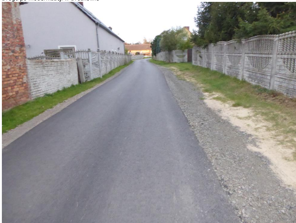
Droga po modernizacji w Lubomyślu
