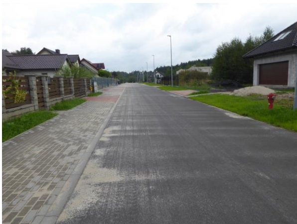
Mirostowice Dolne – ul. Leśna
